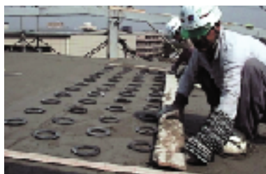
専用定規でO型リングを埋め込みます
