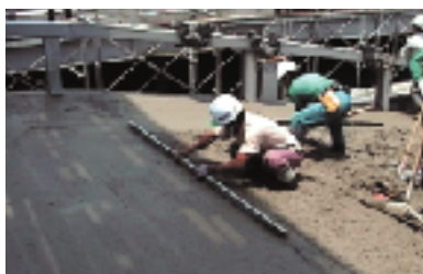
コンクリート打設・ならし作業
