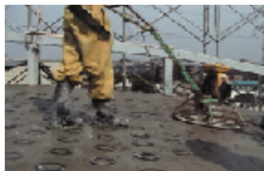
ランプレートによるOリング埋め込み
