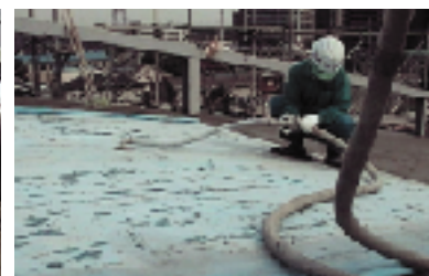
真空ポンプ脱水作業
